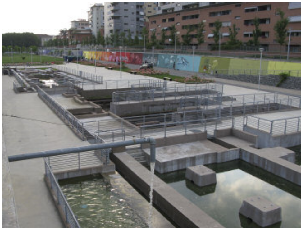
Le vasche di decantazione trasformate in giardini acquatici.
