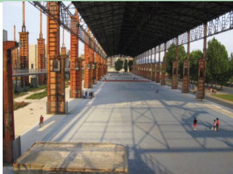
Spra: vista dall'alto del capannone centrale adibito a spazio multifunzionale con campi sportivi e aree gioco.
