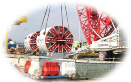
Calaggio TBM Linea M5
